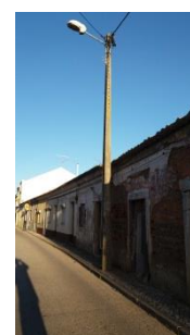
Figura 23 - Tipologia de Iluminação pública
