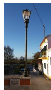
Figura 20 - Tipologia de iluminação pública
