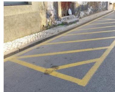
Figura 45 - Elementos construtivos que impedem a circulação nos passeios
