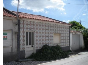
Figura 3 – Exemplo de Edifício Dissonante
