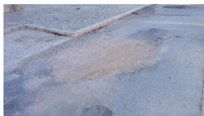
Figura 40 - Marcação de lugares de estacionamento mal executada
