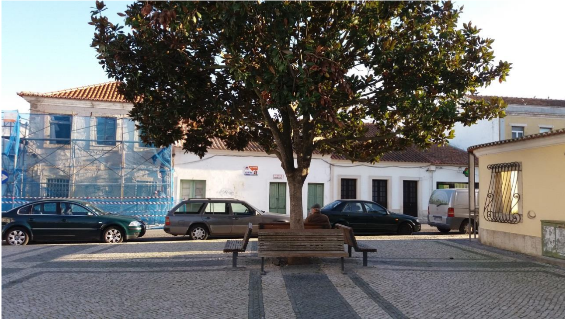
Figura 32 - Praça da República – espaço exterior em bom estado de conservação
