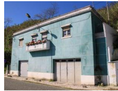
Foto 49 – Risco de segurança das habitações devido à proximidade com a colina
