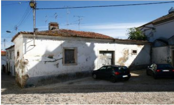
1. Vista geral do edifício
