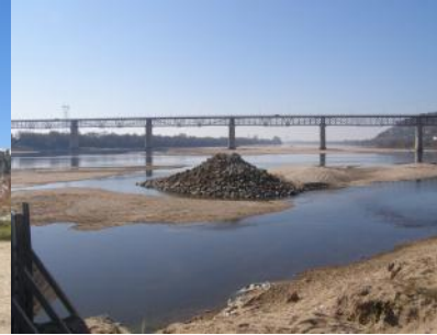
Foto 61 – Sistemas de vistas junto ao Rio
