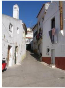
Foto 75 – Vias estreita e com elevada inclinação na estrutura urbana de Alfange
