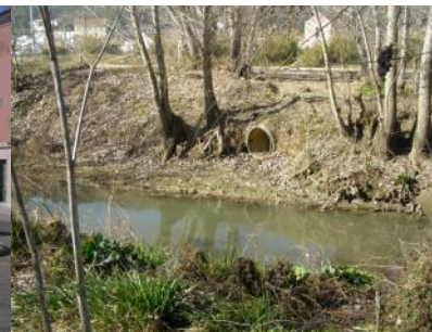
Foto 18 – Saída de esgoto para a ribeira que atravessa a ARU
