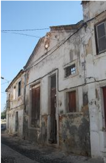
1. Vista geral da fachada
