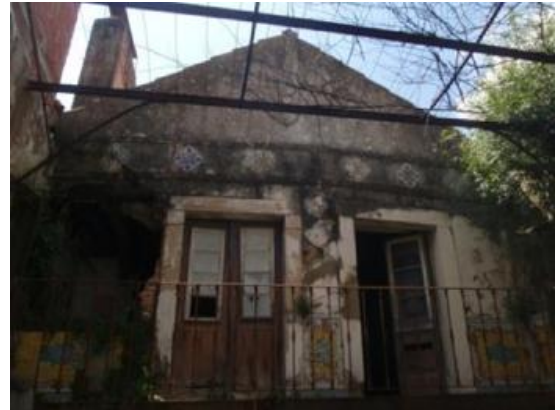
2. Fachada posterior e logradouro
