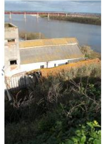
10. Vista da cobertura
