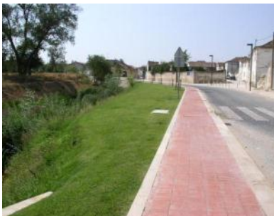
4. Recente reabilitação - Ciclovia
