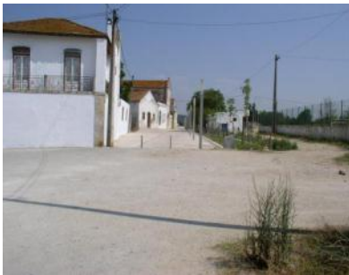
Foto 32– Vista do fim da Avenida Júlio Malfeito
