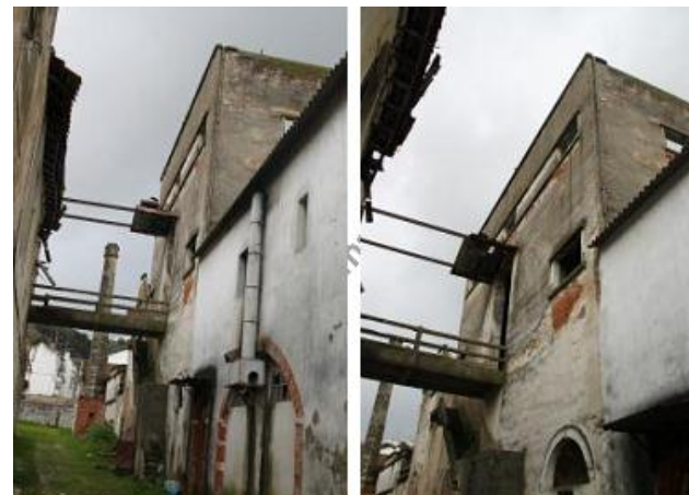
7 e 8. Ligação existente entre edifícios
