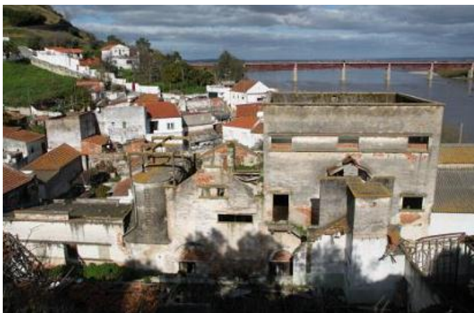
6. Vista geral da fábrica
