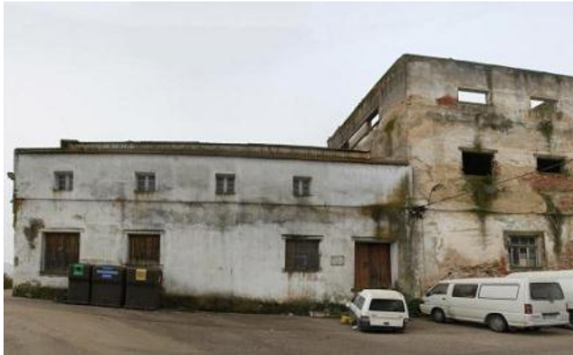
9. Vista geral da fábrica
