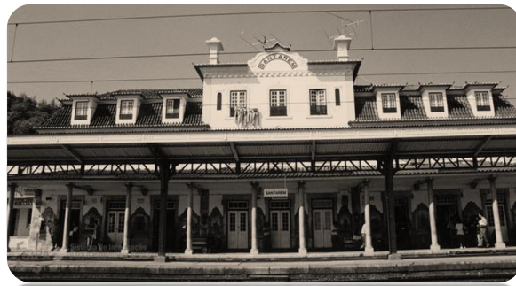
Estação Ferroviária de Santarém
