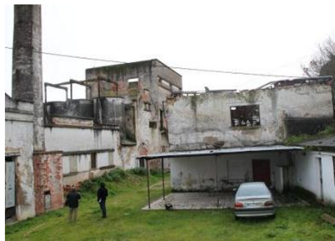
5. Zona envolvente ao edifício
