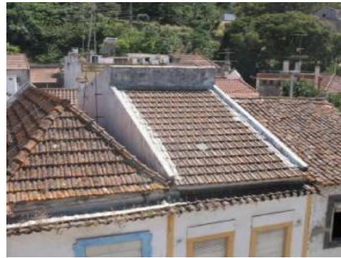
Cobertura com aumento de um piso
