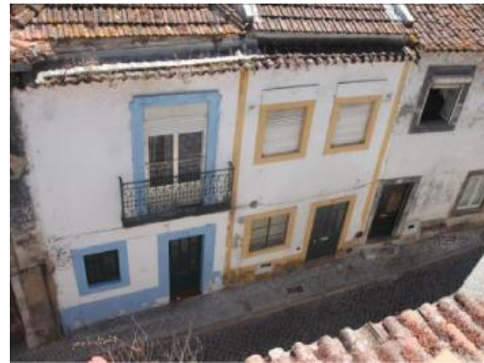
Vista superior do edifício e cobertura
