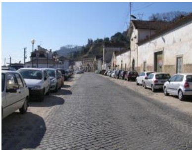
Foto 77 – Estrada da Estação
