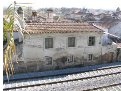
Foto 52 – Proximidade do edificado com a linha férrea
