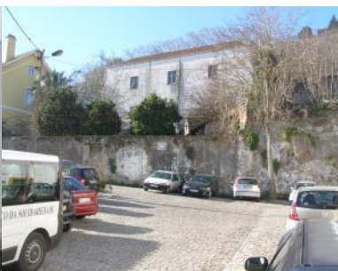
Foto 23 – Vista geral da Rua José Augusto César Silveira
