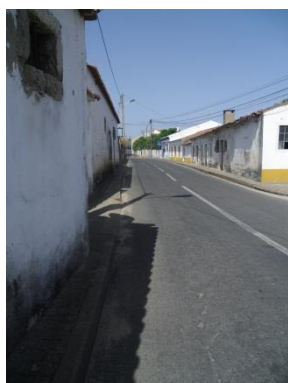
Foto 32 – Passeios adquirem dimensões disfuncionais – rua principal (troço Rua da Alagoa)
