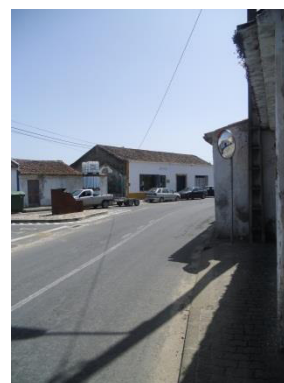
Foto 33 – Passeios adquirem dimensões disfuncionais – rua principal (troço Rua da Alagoa)
