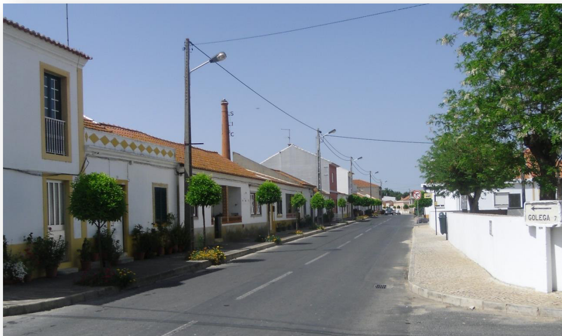
Foto 1 – Rua do Espírito Santo – Eixo estrutural de Azinhaga
