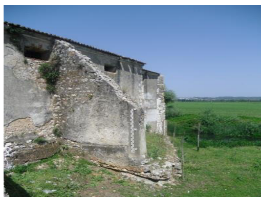
Foto 21 – No contraforte de uma Capela localizada na margem do Rio Almonda é possível ver uma escala para contabilização da altura da água das cheias
