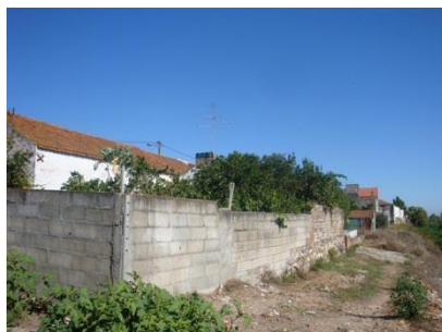
Foto 18 – Margens do Rio Almonda – Situações de tardoz
