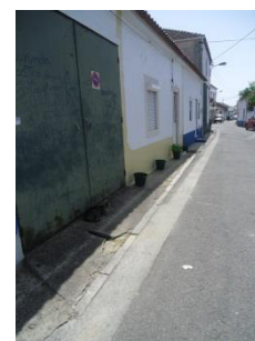
Foto 30 – Arruamentos com passeios mal dimensionados - Rua Nova de St.º António
