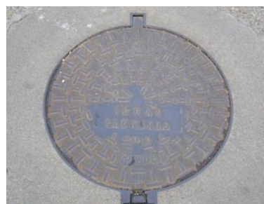
Figura 19 – Foto tampa rede PLU
