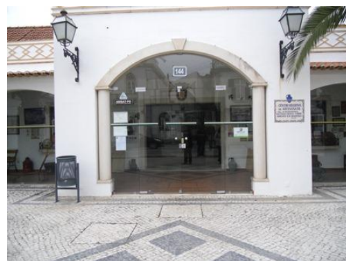
Figura 73 –Edifício Centro Regional de Artesanato
