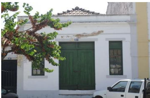
Vista edifício Rua Direita São Pedro
