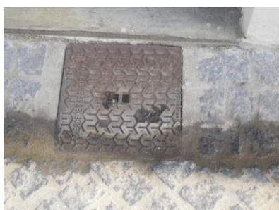
Figura 22 – Foto caixa ramal DOM
