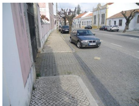
Figura 41 – Vista de via pedonal, passeios em calçada.
