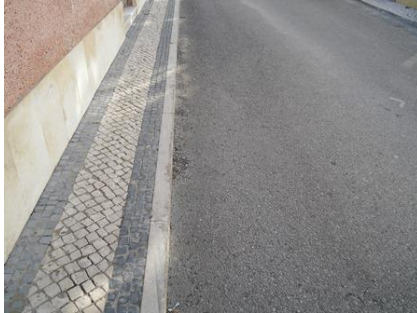
Figura 57 – Vista de passeio com dimensões reduzidas
