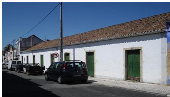
Vista edifício Rua Câmara Pestana
