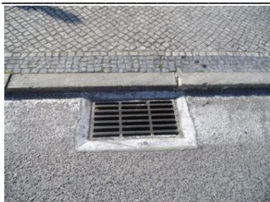
Figura 20 – Foto sumidouro PLU
