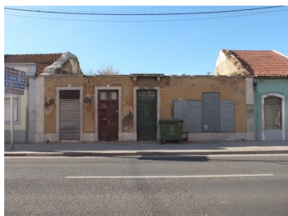
Figura 31 – Degradação do edificado
