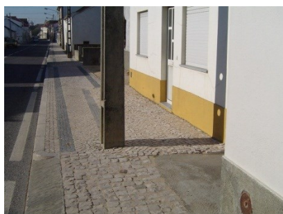
Figura 16 – Posto de eletricidade nos passeios
