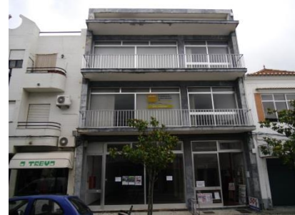
Figura 3 – Exemplo de Edifício Dissonante
