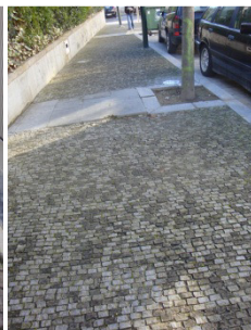
Figura 24 – Calçada de granito
