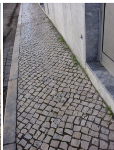
Figura 23 – Calçada de calcário
