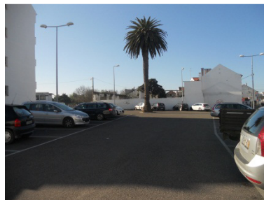
Figura 16 – Espaço criado para estacionamento, derivado à demolição de edifícios – Rua 5 de Outubro
