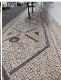
Figura 22 – Calçada à portuguesa
