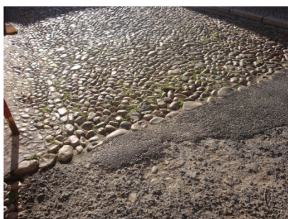
Figura 48 – Pavimento em seixo – Beco na Rua 5 de Outubro
