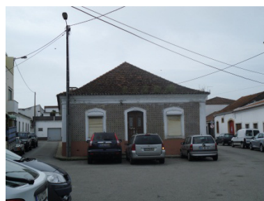
Figura 52 – Estacionamento inadequado no Largo dos Combatentes da Grande Guerra
