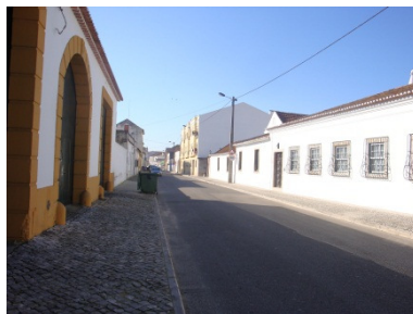
Figura 32 – Rua Miguel Bombarda – Bom estado de conservação
