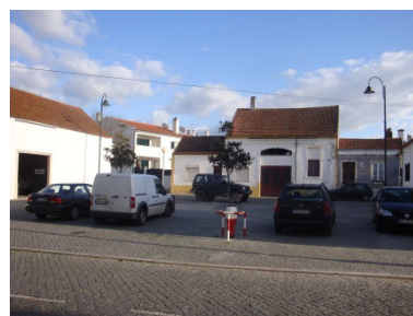
Figura 53 – Apropriação do Largo Espírito Santo para estacionamento
