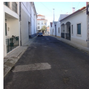
Figura 33 – Travessa da Quintinha – estado de conservação Médio
