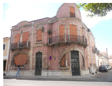
Figura 41 – Edifício considerado notável, em avançado estado de degradação. Rua Dr. Francisco
