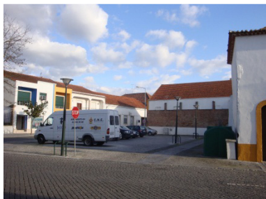
Figura 15 – Espaço criado para estacionamento, derivado à demolição de edifícios – Rua Manuel Minderico
