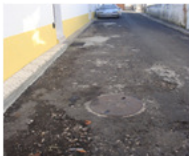
Figura 35 – Travessa das Ribeiras – Péssimo estado de conservação
