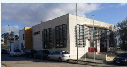
Edifício de serviços da CIMLT
