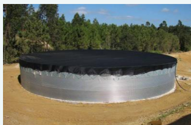
Reservatório de água
