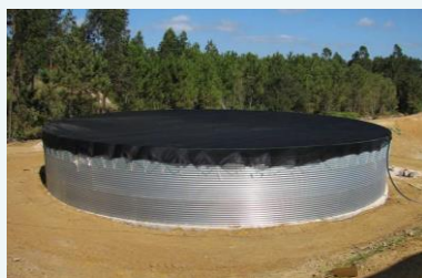
Reservatório de água
