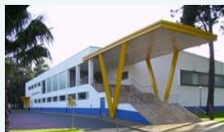
Pavilhão Desportivo de Salvaterra
