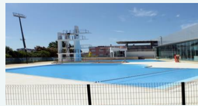
Complexo Piscinas: Tanque de saltos e tanque exterior
