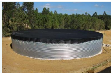
Reservatório de água
