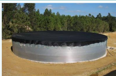
Reservatório de água
