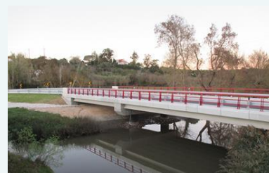
Canal de Azambuja, no Cartaxo (Ponte do Reguengo)
