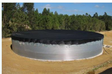
Reservatório de água
