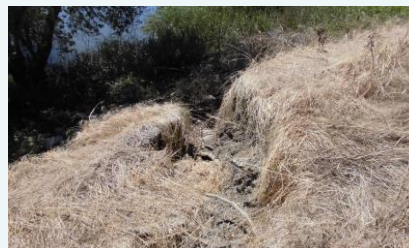
Deslizamento/ Rombo de vertente / Dique em Vila Nova da Rainha
