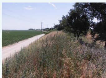
Dique de Valada coberto de vegetação
