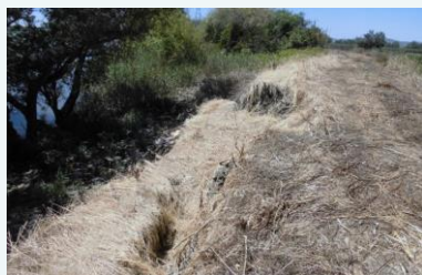
Deslizamento/ Rombo de vertente / Dique em Vila Nova da Rainha
