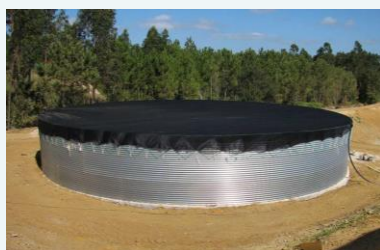
Reservatório de água
