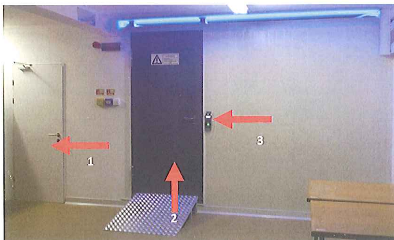
Imagem 1 – Exterior do DataCenter da CIMLT
