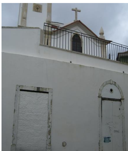
Vista do edifício
