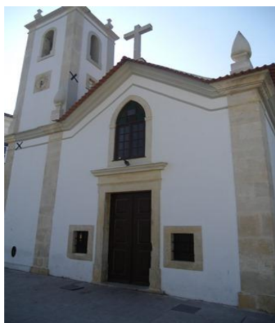
Vista do edifício
