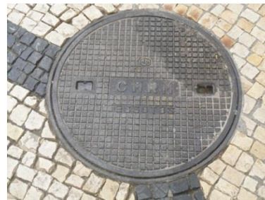
Figura 15 – Foto tampa rede PLU
