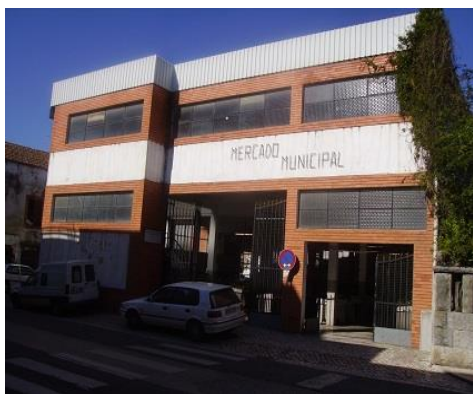
Figura 12 – Mercado Municipal antes da remodelação
