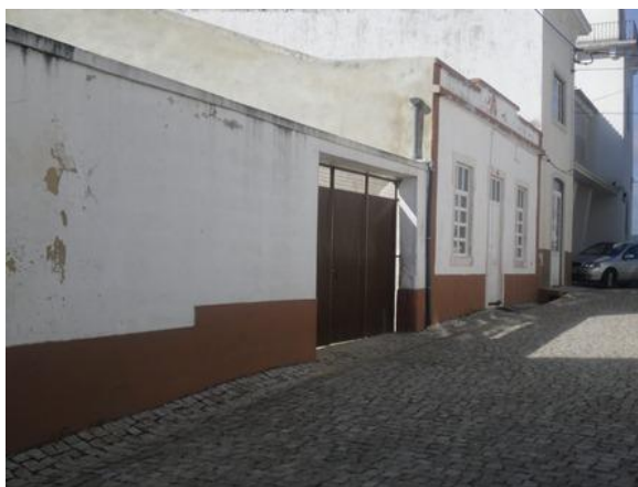
Vista do edifício
