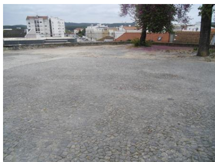
Figura 10 – Vista sobre o Largo
