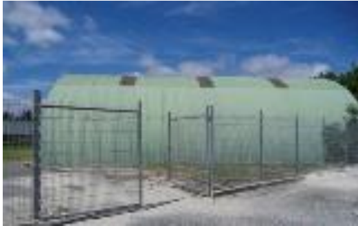
Vista geral zona coberta
