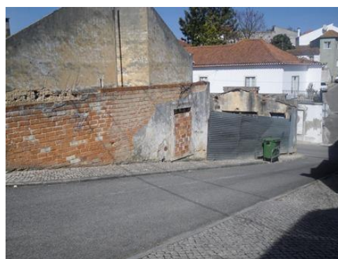
Vista do edifício Rampa dos Bombeiros
